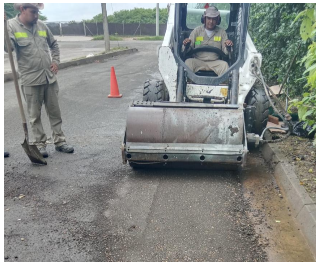
Utilización de asfalto frío sostenible para el mantenimiento vial
